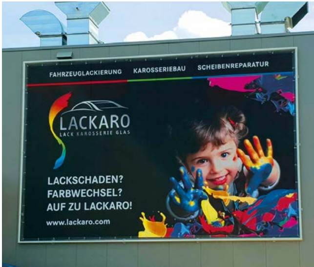
Montage von Spannrahmen für Fassadenbanner, Lackaro GmbH i.A. der Werbeagentur Fortuna GmbH
