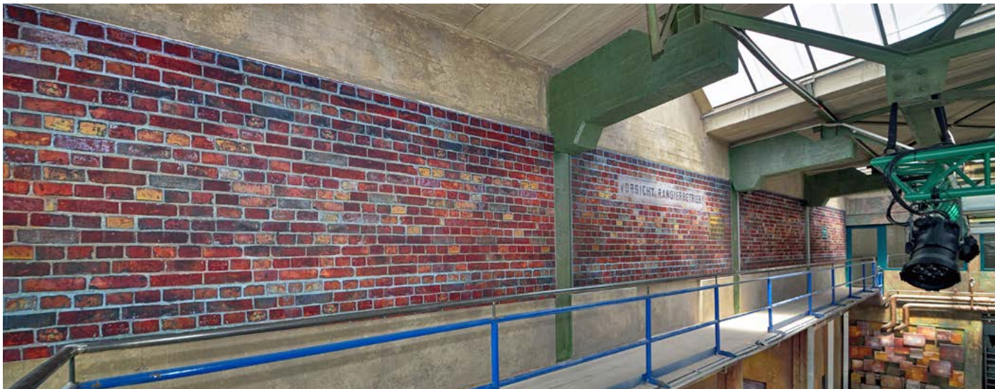
Wandverkleidung, KRAFTVERKEHR Event GmbH
