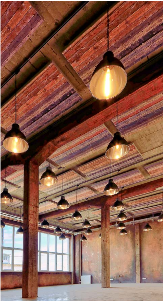
Akustikpaneele, KRAFTVERKEHR Event GmbH
