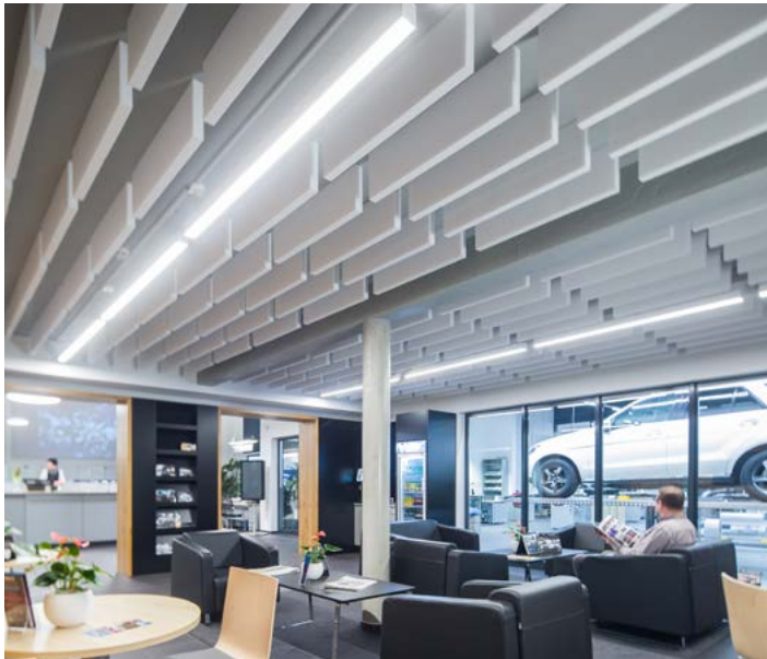
Baffeldecke, Serviceannahme Schloz Wöllenstein GmbH & Co. KG
