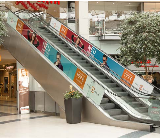
Rolltreppenklebung, Allee-Center Leipzig
